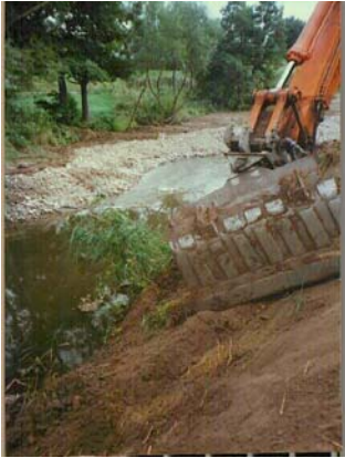
Släntberedning av befintliga ler och sandmassor
